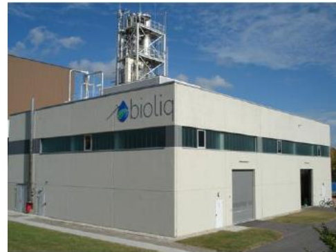
รูปที่ 3-7 แผนผังการทำงานและภาพโรงงาน Fast Pyrolysis ระดับภาคสนามขนาดอัตราป้อนชีวมวล 500 กิโลกรัม/ชั่วโมง ของ KIT [18, 19]
